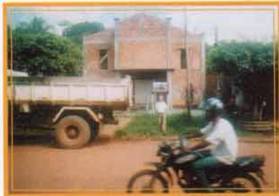
Fachada do templo em fase de acabamento
