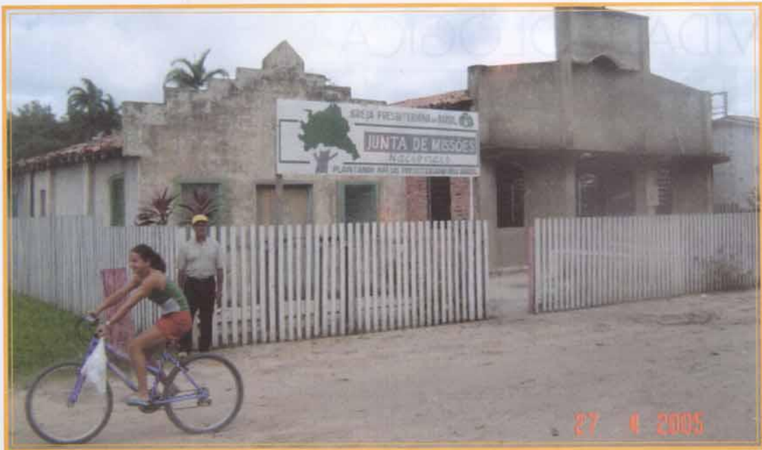
Mis. Salustiano e Lilian. Vista externa da construção – Itaquara/PA
